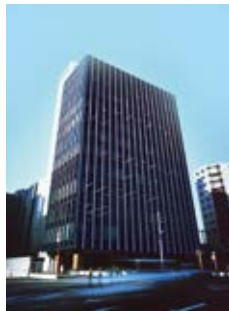
(株)ロッテの本社ビル
